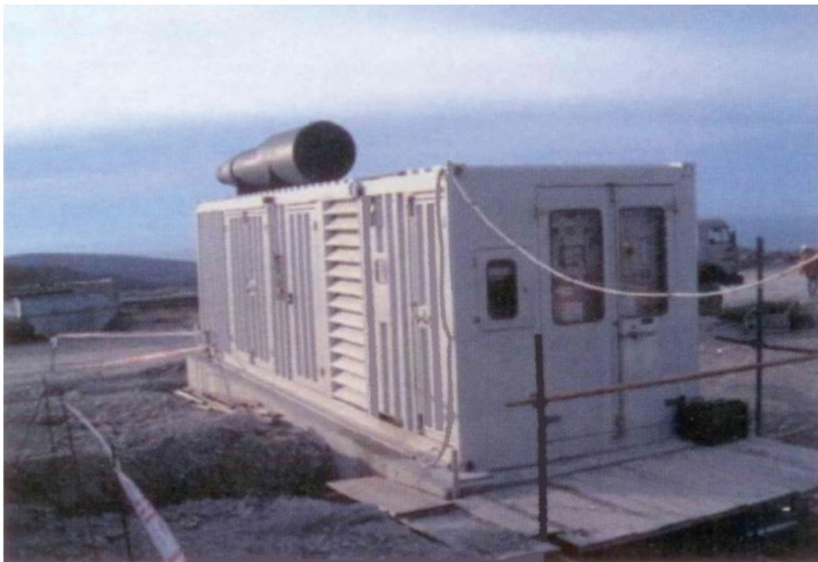
*Рис. 3. Резервное электроснабжение объекта на базе дизель-генераторных установок в модульном контейнерном исполнении*
