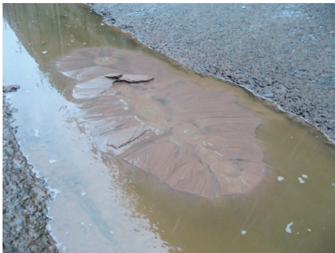
Рис. 11. Вынос грунта на осевой шпонке секции № 13 (а), замер объема выноса (б)
