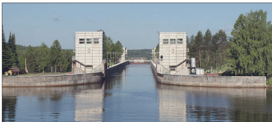
Рис. 2. Общий вид шлюза № 3 Новинкинского гидроузла
