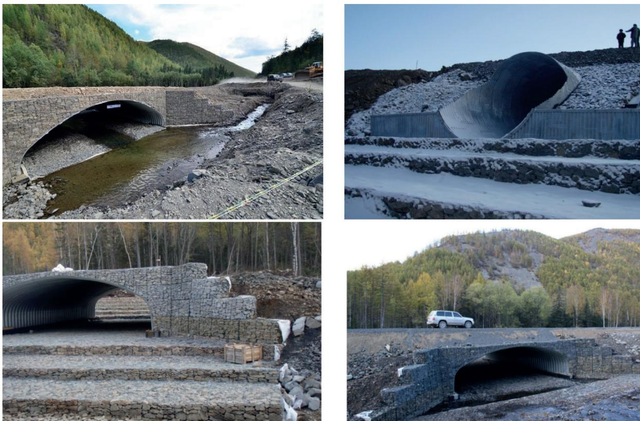
Рис. 1. Водопропускные сооружения из гофрированных труб на трассе Хабаровск – Лидога – Ванино
