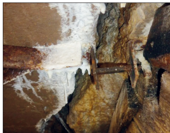
Рис. 2. Выщелачивание вдоль трещины
