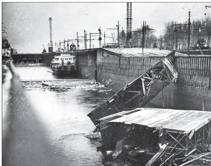
Рис. 4. Последствия аварии на Пермском шлюзе
