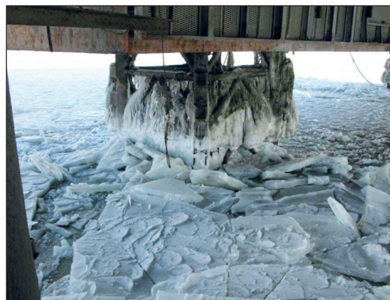
Рис. 2. Ледовые образования на ферменных опорах СПБУ пр. 1540
