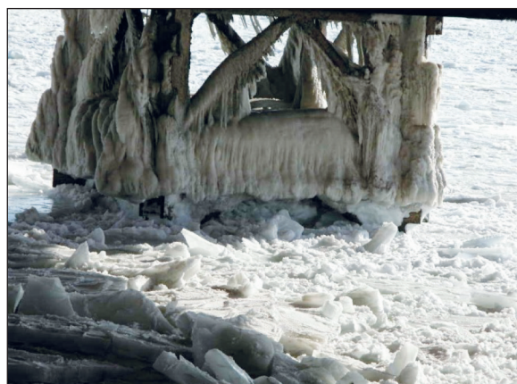
Рис. 2. Ледовые образования на ферменных опорах СПБУ пр. 1540
