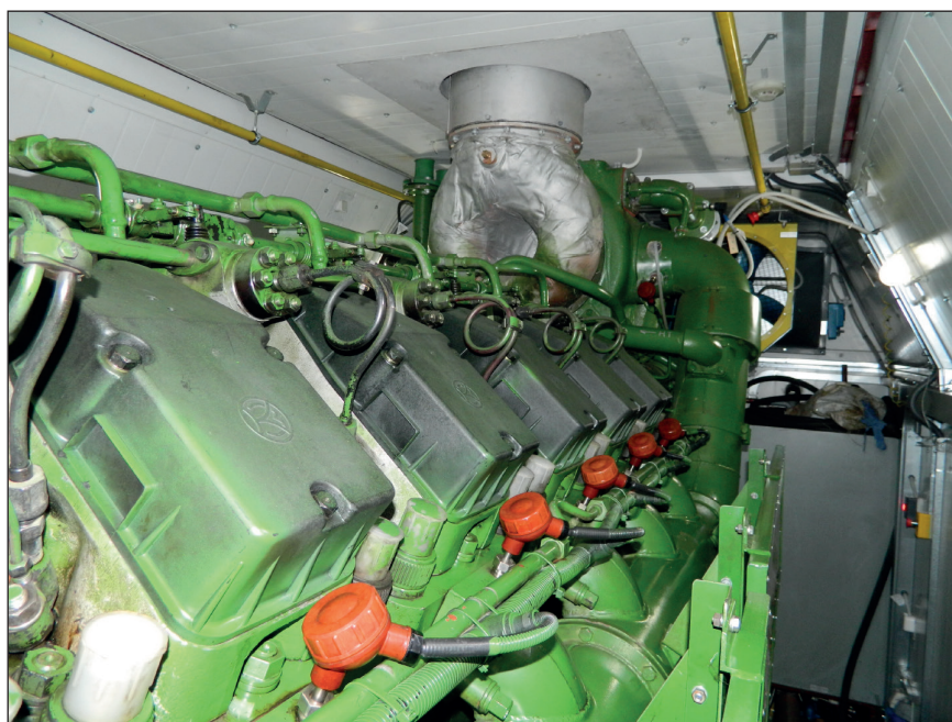
Рис. 2. Газонефтяной дизель 12 ГДЧН 26/26 семейства Д49
