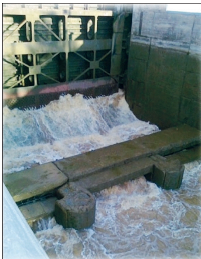
Рис. 2. Головная безгалерейная система наполнения камер шлюзов № 1–6 Волго-Балтийского водного пути:
