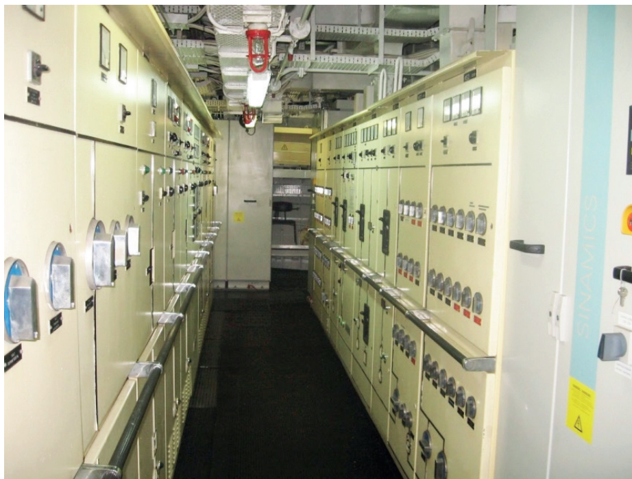
Рис. 6. ЩЭД (слева) и ГРЦ (права) в помещении аппаратной
