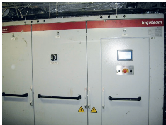
Рис. 5. Оборудование гребной электрической установки:
