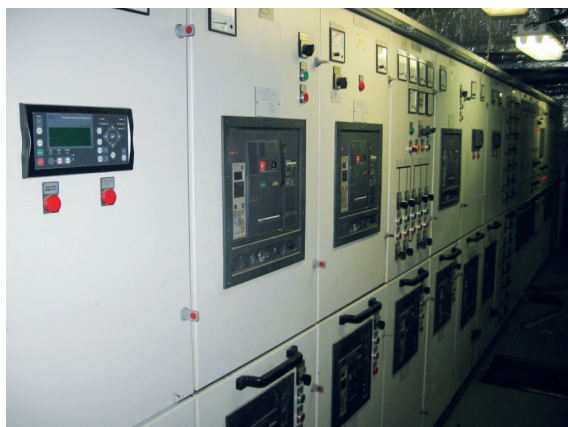
Рис. 5. Оборудование гребной электрической установки:
