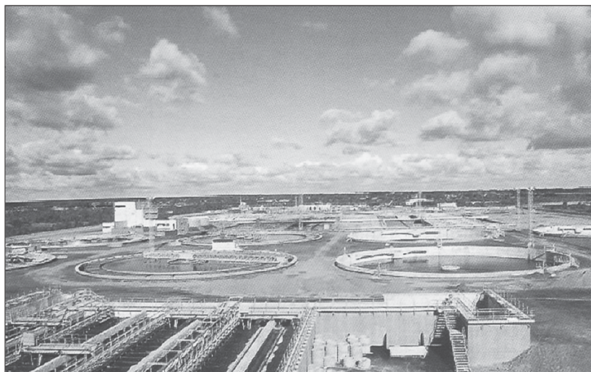
Юго-Западные очистные сооружения (ЮЗОС)
