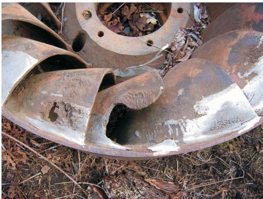
Рис. 3. Истирание и изнашивание лопастей турбины от наносов
