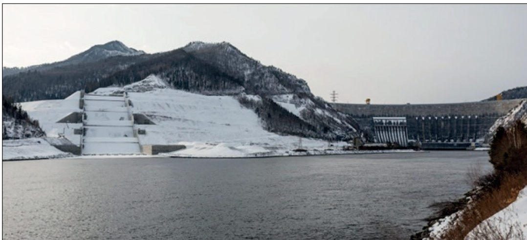
Рис. 1. Вид на Саяно-Шушенскую ГЭС и береговой водосброс с нижнего бьефа
