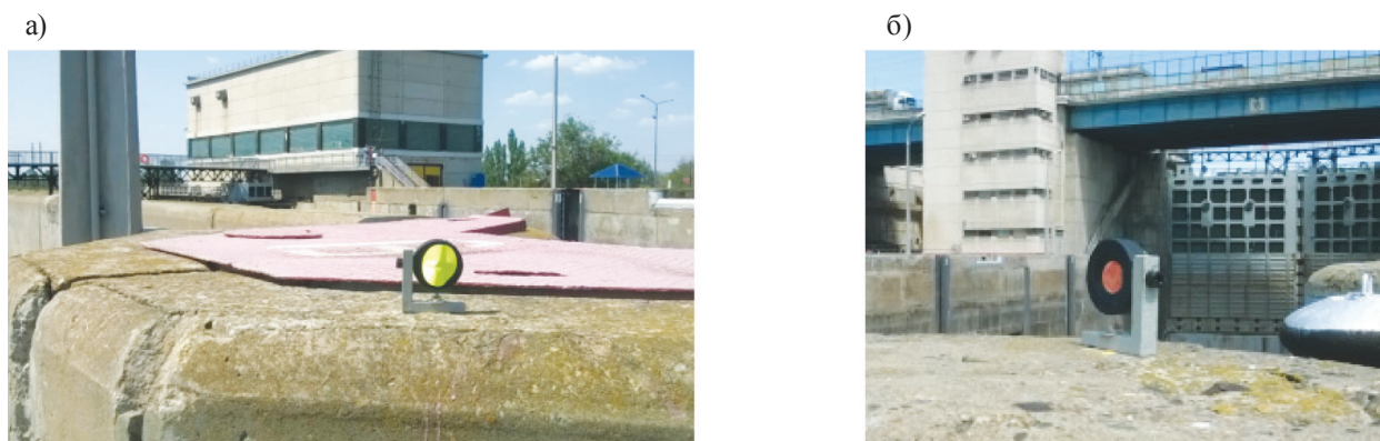
Рис. 5. Установка отражательных призм на секциях шлюзов: а — призма на камере плавучего рыма; б — призма на ограждении секции камеры
