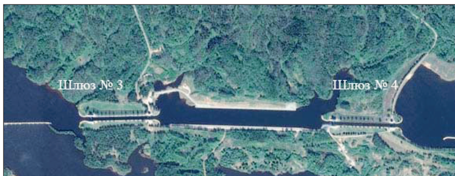
Рис. 1. Новинкинский гидроузел Волго-Балтийского канала
