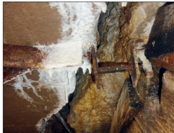
Рис. 2. Выщелачивание вдоль трещины
