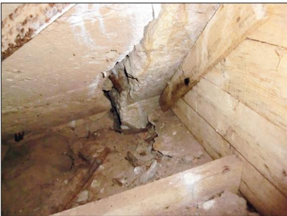
Рис. 1. Трещина в монолитном бетоне левобережного устоя нижней головы
