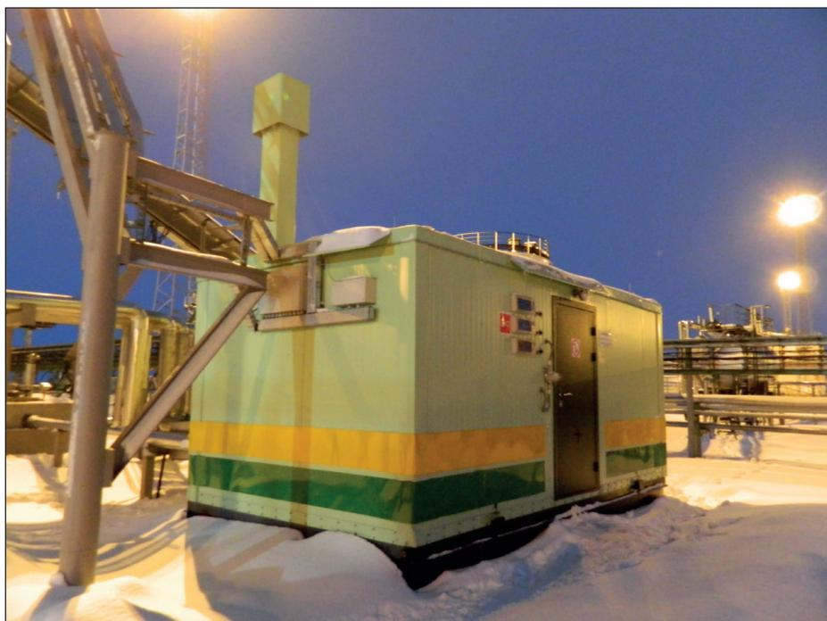
Рис. 3. Установка подготовки нефти, размещенная в контейнере
