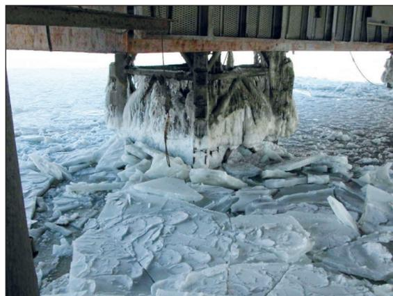
Рис. 2. Ледовые образования на ферменных опорах СПБУ пр. 1540
