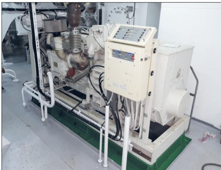
Рис. 3. Вспомогательный судовой дизель-генератор
