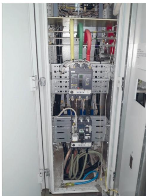
Рис. 5. Секция вентильного ДГ в составе ГРЩ
