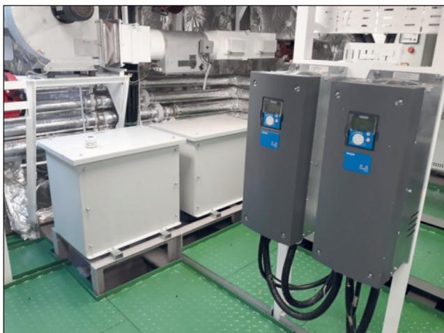
Рис. 4. Полупроводниковые модули (справа) и фильтры (слева)
