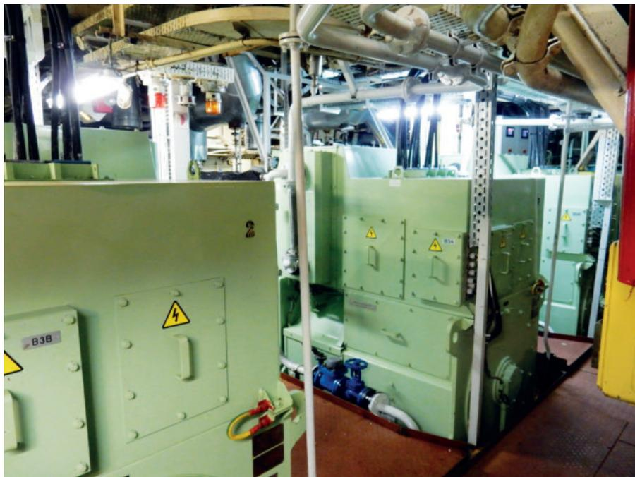
Рис. 3. Главные дизель-генераторы в машинном отделении судна
