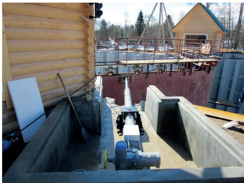
Рис. 3. Пример установки электромеханического привода типа электроцилиндр шлюза № 5 Северо-Двинской шлюзованной системы
